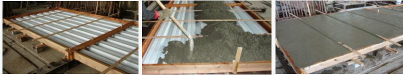
а) монтаж листов профнастила и опалубки б) укладка бетонной смеси в конструкцию плиты в) выдерживание бетонной смеси Рисунок 1 – Устройство сталежелезобетонной плиты перекрытия (покрытия)
